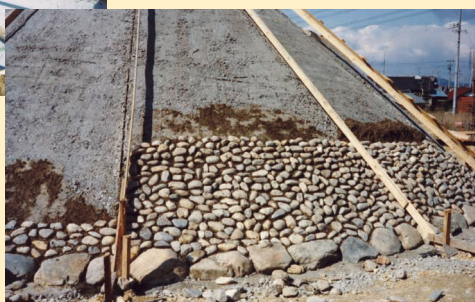
墓石の復元工事
