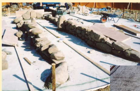
横穴式石室の移設復元工事
