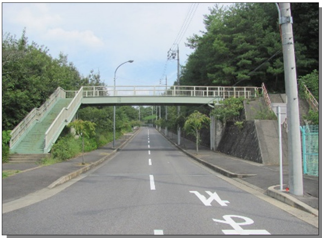
玉野台北歩道橋
