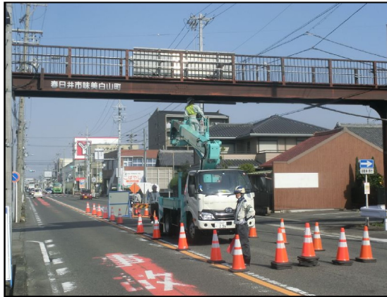
写真-3.1 専門業者による点検状況①
