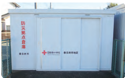
防災拠点倉庫
