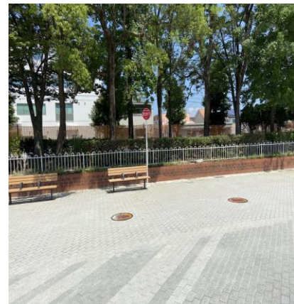
耐震性防火水槽
