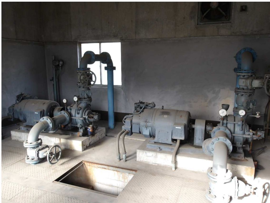
資料 2 水道施設（地中埋設配水管含む） 写真
