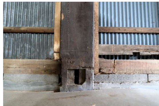
4 ホール東面 大黒柱脚部（敷居跡）
