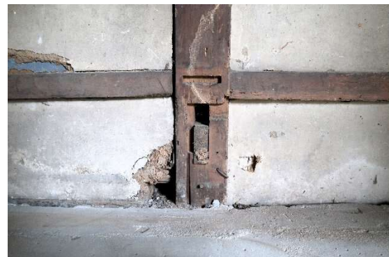
8 事務室西面 御座ノ間床脇柱（敷居跡）
