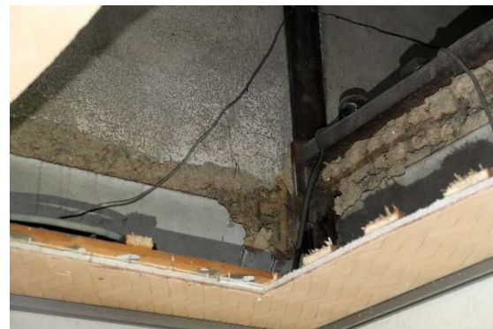
6 ホール南西隅 天井裏（旧天井跡）
