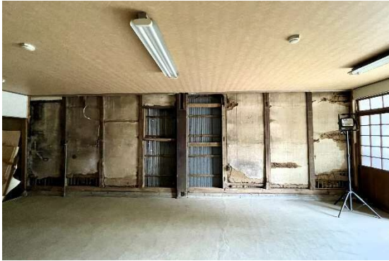
1 ホール東面 壁面全面
