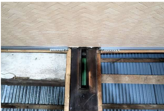
3 ホール東面 大黒柱頂部（鴨居跡）
