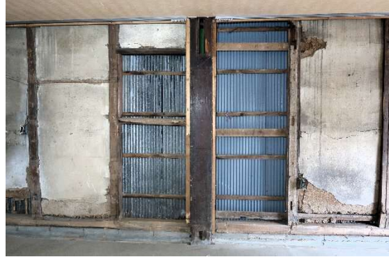
2 ホール東面 中央大黒柱
